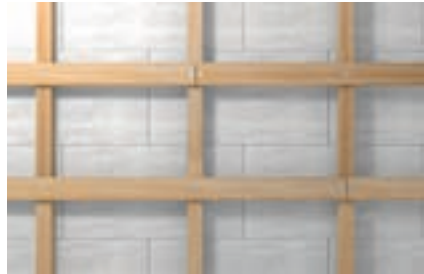
Holzunterkonstruktionen
