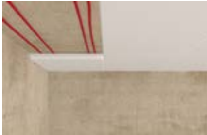
Dämmplatten an der Decke
