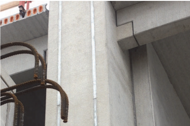
Vertikale Halfen HTU Profilblech-Befestigungsschiene zur Befestigung der Fassadenbekleidung
