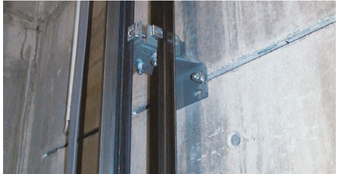
Befestigung einer Führungsschiene im Aufzugsbau
