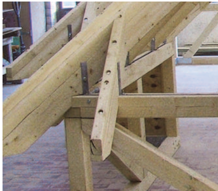
Holzdachkonstruktion mit Halfen HNA Nagelanschlussanker
