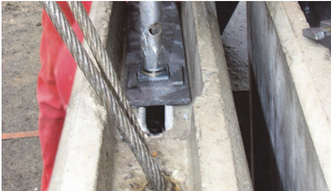
HVL-Fertigteilverbindung in Betonfertigtelementen
