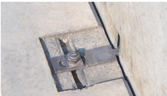
Fertigteilverbindung; Halfen HKZ Verankerungslasche mit gezahnter Gegenplatte
