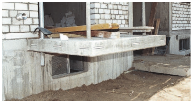
Fertig einbetonierte HGB Schiene, Wohnungsbau
