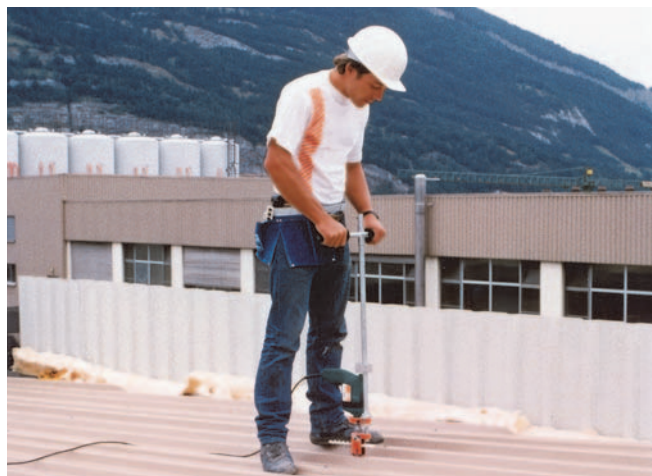
Verschraubung der Stahltrapezbleche mittels Selbstbohrschrauben
