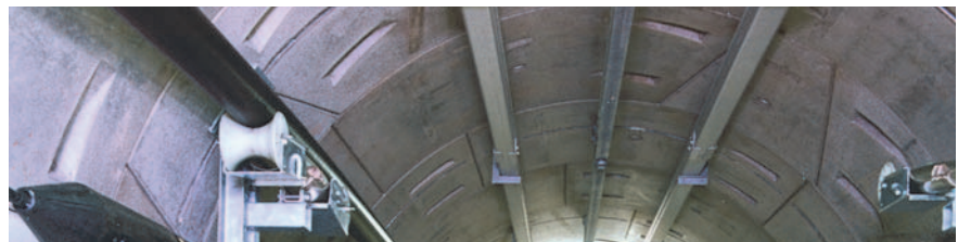
Gebogene Halfenschienen in Tübbing-Elementen
