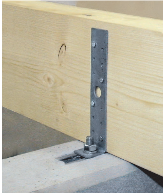
Verbindung von Holzkonstruktionen und Betonelementen z.B. Halfenschiene mit HNA WN 185 Nagelanschlussanker
