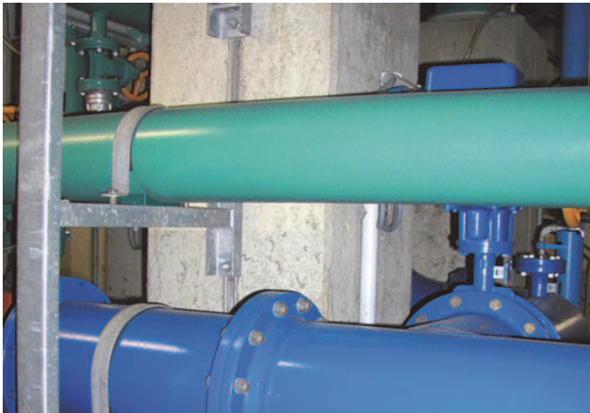
Rohrleitungsunterstützung an senkrechter HZA Schiene
