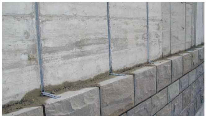
Mauervorsatzschale mit Halfen ML Maueranschlussankern
