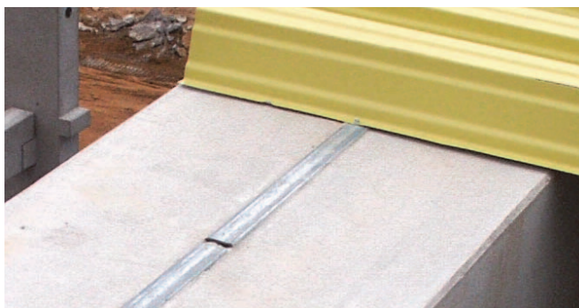
Trapezblechbefestigung im Dachbereich
