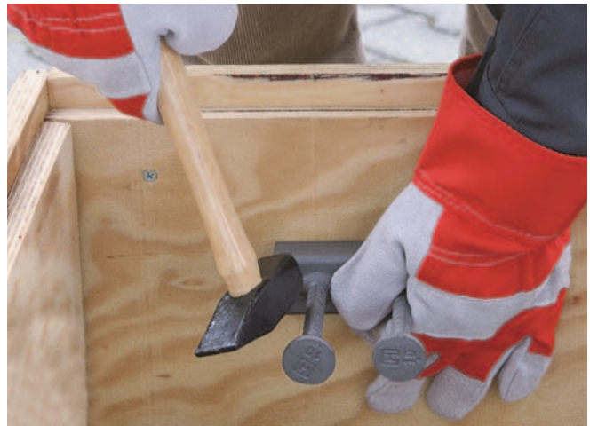
Halfenschienen an die Schalung annageln
