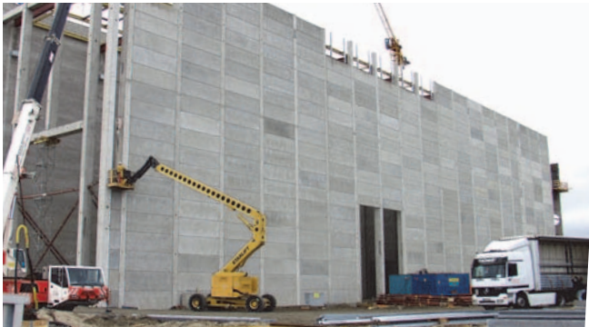
HVL-System Anwendung; Betonfertigteilelemente werden mit HVL an den Stützen befestigt; Airbus Lackierhalle
