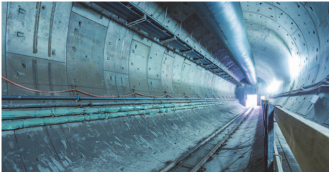
Befestigung von Versorgungsleitungen in TBM-Tunnel mit HTA-CS
