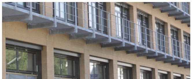
Befestigung von Fluchtwegen/Fluchtbalkonschwert (senkrechte Ausrichtung der Halfen Ankerschienen)
