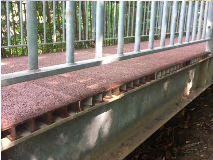
Brücke Kolkwitz/ Zahsow
