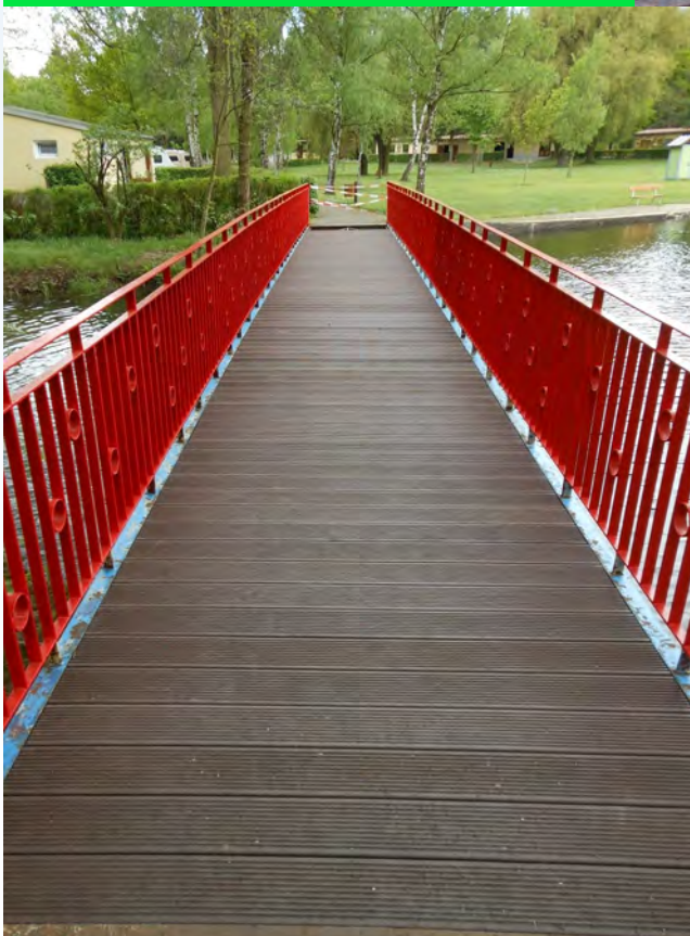
Neuer Belag: Stegbohle 4 x 17 cm mit Nut und Feder
